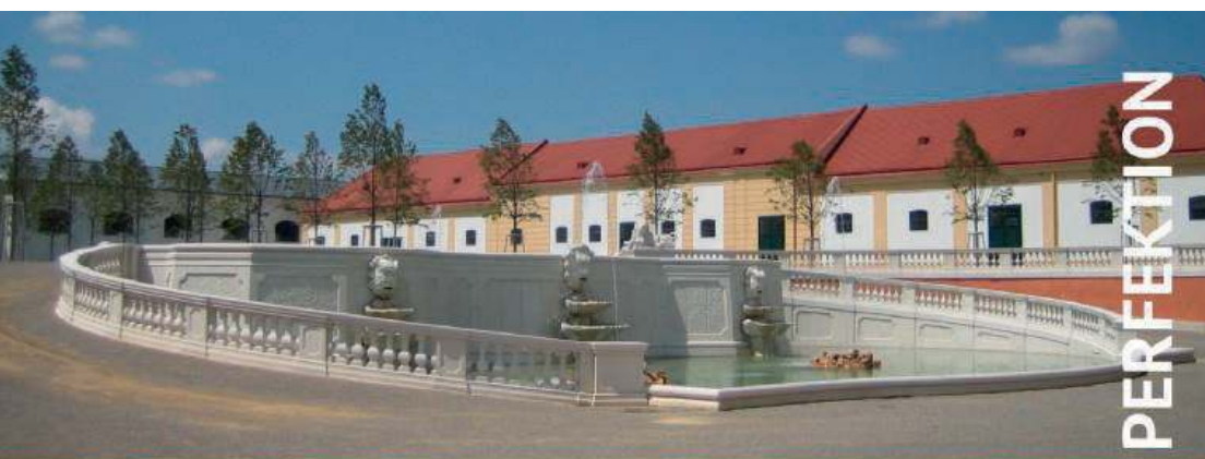
Projekt: Rekonstruktion der barocken Brunnenanlage | Neptunbrunnen Schloss Hof, Niederösterreich
